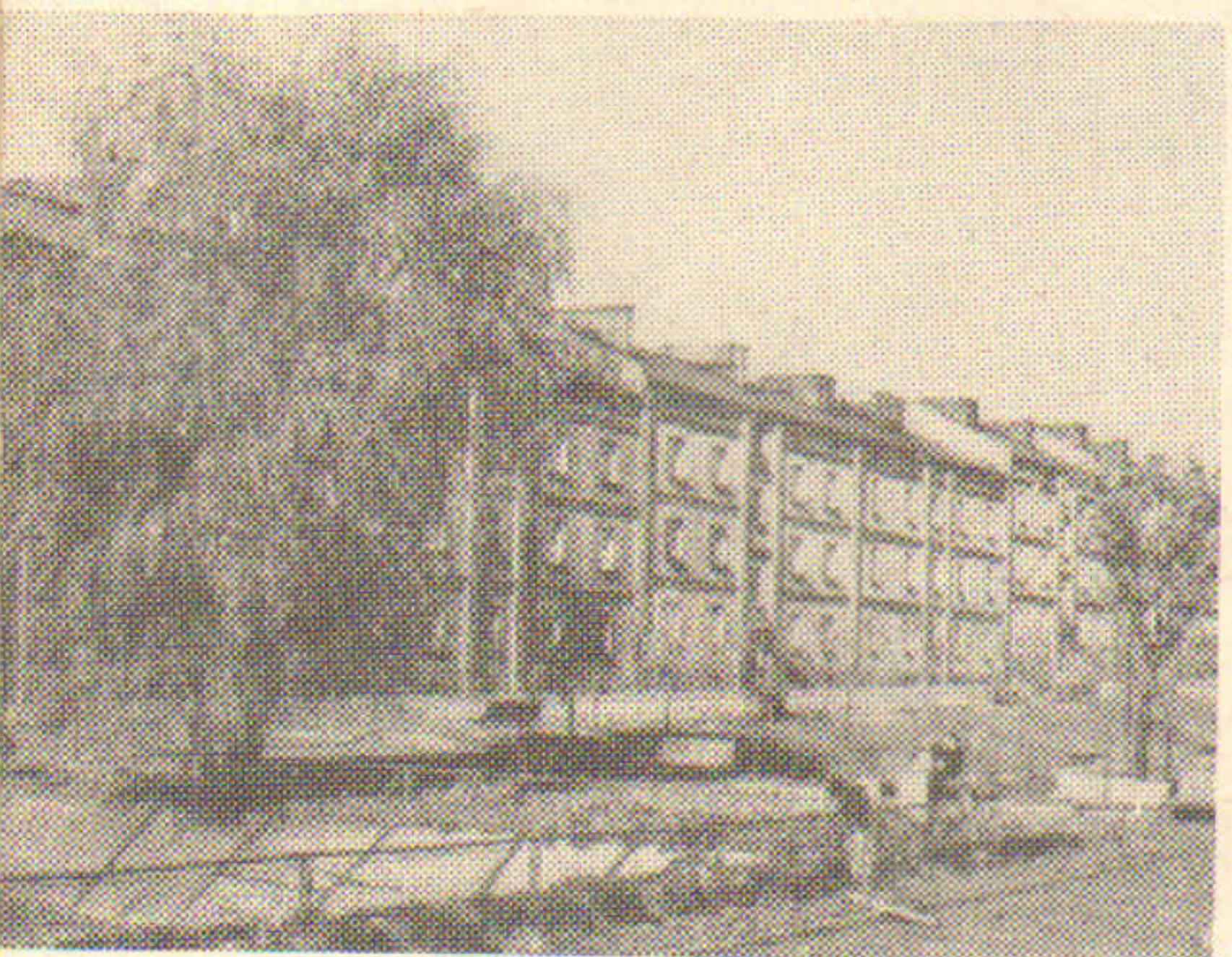
Przebudowana po kapitalnym remoncie tzw. „kamienica” przy ul. Głównej.
